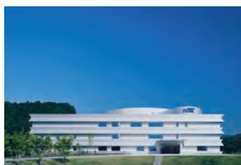
本社棟（RD1棟）
